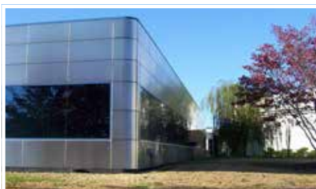
Gevel voor en na de reiniging. Foto: York Property _Façade avant et après le nettoyage. Photo : York Property
